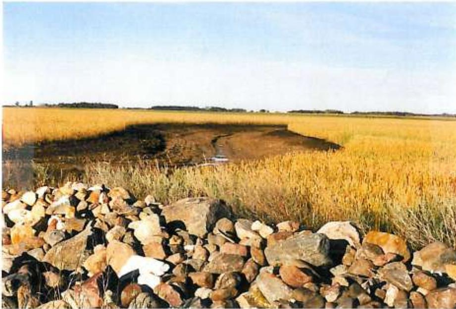
**ONE OF THE MAN-MADE SWALES TO CONTROL SPRING RUN-OFF**
